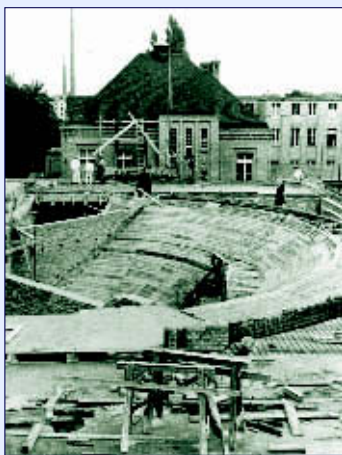
Der Neubau des Zentralen Hörsaals auf dem Fundament des Klinik-Bunkers, 1954
